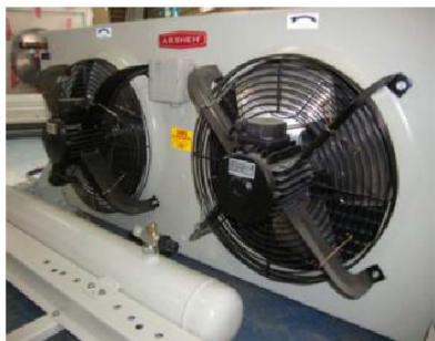
سطح فین های کندانسورهای کندانسینگ را همواره بازدید و در صورت نیاز با توجه به آلودگی محل نصب بطور مرتب توسط جریان باد تحت فشار نظافت کنید. برای شستشوی سطوح فین های کندانسور از مواد شیمیایی مجاز استفاده کنید. مواد شیمیایی حاوی اسید موجب خوردگی فین ها و لوله مسی خواهند شد. فن های کندانسور را هر ۶۰ روز یکبار بازدید کنید.
