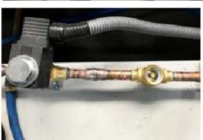
میزان شارژ گاز مدار تبرید از طریق رویت سایت گلاس مدار مایع
