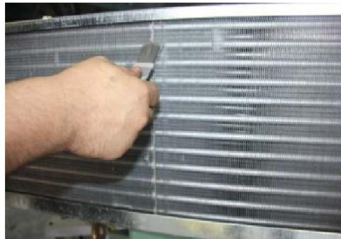
محل نصب کندانسینگ یونیت و تابلوی اصلی موتور خانه را بطور مداوم تمیز و پاکیزه نگه دارید. همواره قسمتهای مختلف کوئل کندانسورها، اتصالات و زانوی مسی و کندانسینگ یونیت را بدقت بازدید کنید، وجود لکه روغن در این نقاط نشان از وجود نشت گاز مبرد می باشد پس از نظافت کامل نسبت به رفع نشیق یگاز مبرد اقدام کنید. انجام عمل شارژ باید توسط افراد آموزش دیده صورت گیرد.
