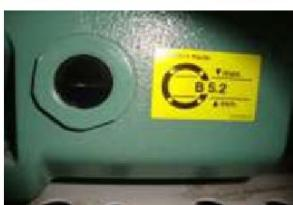
سطح روغن کارتل کمپرسور هارا به طور دائم کنترل کنید.
